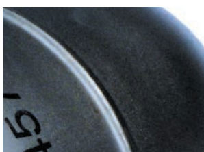
Abbildung: Homogene Schwimmer- Schweißnaht.
